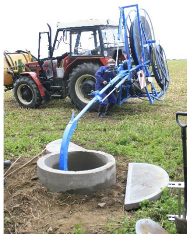
Obr. 2 Použití hydročističe při údržbě svodného drénu s přístupem z drenážní šachtice.
